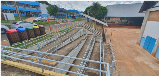
Rampas de acesso - rotas acessíveis até as quadras poliesportivas
