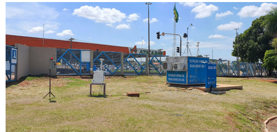
Estação de Qualidade do Ar - UFMS
