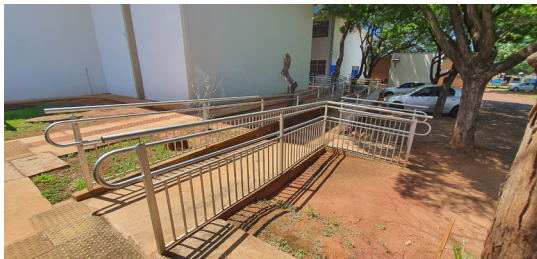
Rampas de acesso com piso tátil
