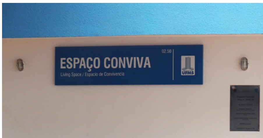
Fachada de unidade
